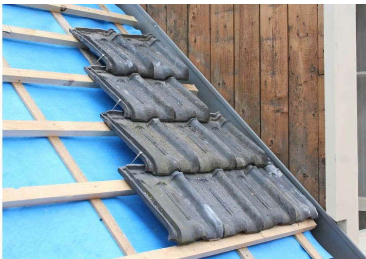
Figuur 13: Voor het deugdelijk verankeren van deze kruispannen is het kiezen van de juiste panhaak essentieel.
