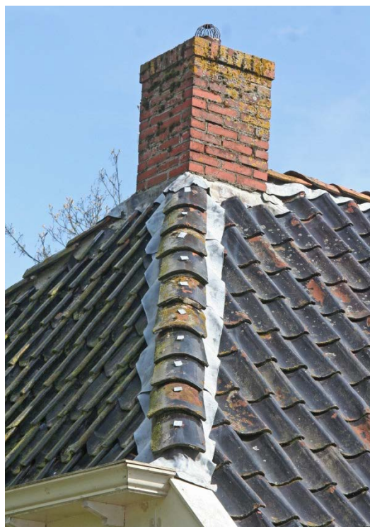
Figuur 7: Karakteristieke afwerking van nokken en kepers in Noord-Nederland met loodstroken onder de vorst- en keperpannen.
