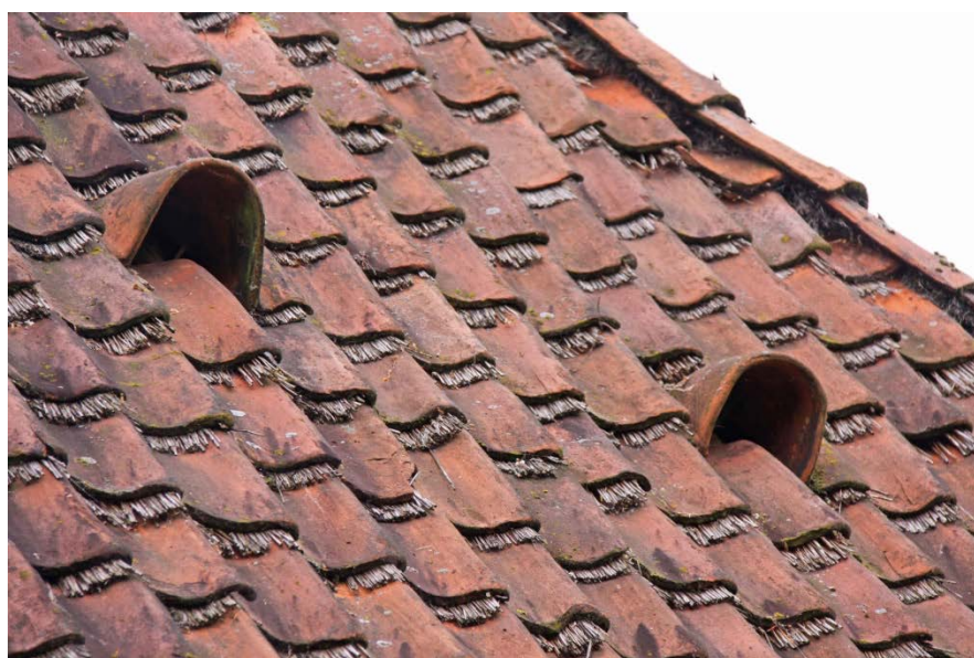
Figuur 3: Een zojuist opgeleverd historisch pannendak voorzien van strodokken, met twee licht- of luchtpannen.
