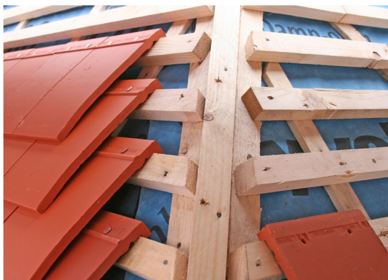
Figuur 11: Vernieuwen in de categorie 3B Imiteren met nieuwe leipannen. De leipannen worden op latten aangebracht. De juiste overlap plus latafstand staat in de ontwerp- en uitvoeringsrichtlijnen voor dakbedekkingsconstructies met keramische en betonnen leipannen PBL 24-103: 2011.
